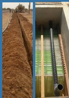
Extensions de réseau et renforcement d'une station de potabilisation
