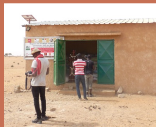
Magasins de stockage d'aliments de bétail
