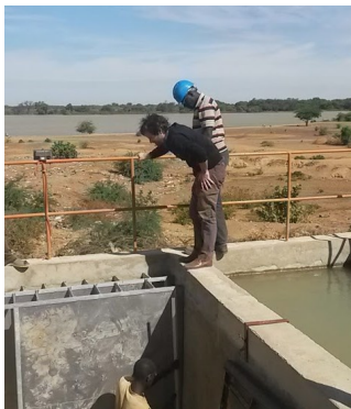
Travaux d'extension du décanteur de Bokhol
