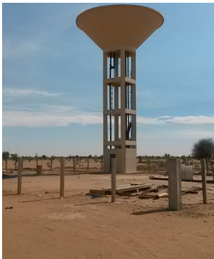
Château d'eau de 100m 3 sur 15m à Weyndou Diami
