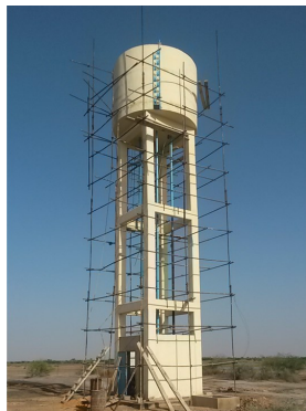
Château d'eau de 50m 3 sur 15m à Diagambal
