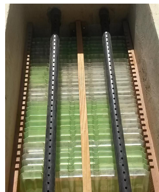
Travaux de réhabilitation du décanteur de Diagambal
