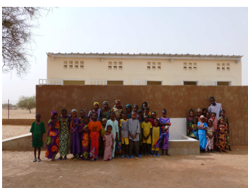
Nouveau Bloc sanitaire construit à l'école de Léwa
