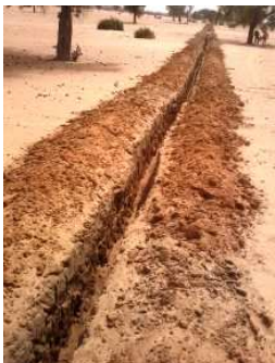
Réalisation des tranchées à Mbane
