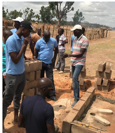
Formation de maçons
