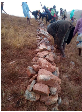
Mise en place des cordons pierreux en amont
