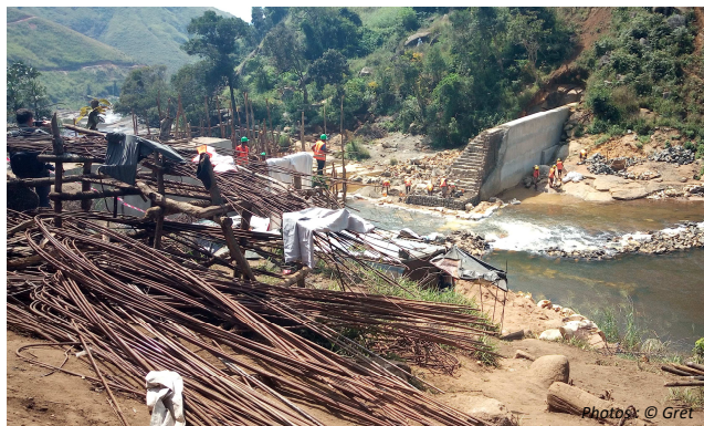
Construction du barrage de la centrale de Bealanana,
